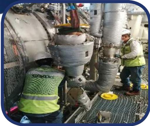
Montaje de mantas térmicas, Turbina de Gas ERI32. Bloque 30.
