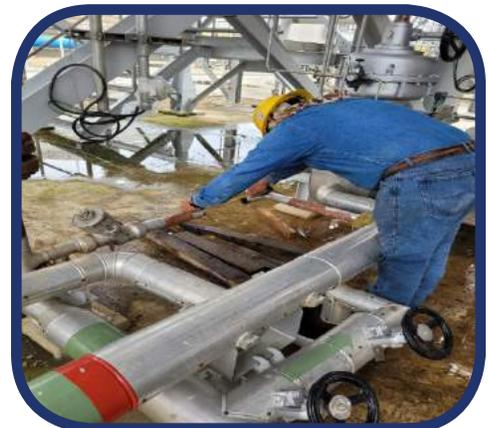
*Medición con precisión para reemplazo de nueva válvula caldero HRSG42. Bloque 40.*
