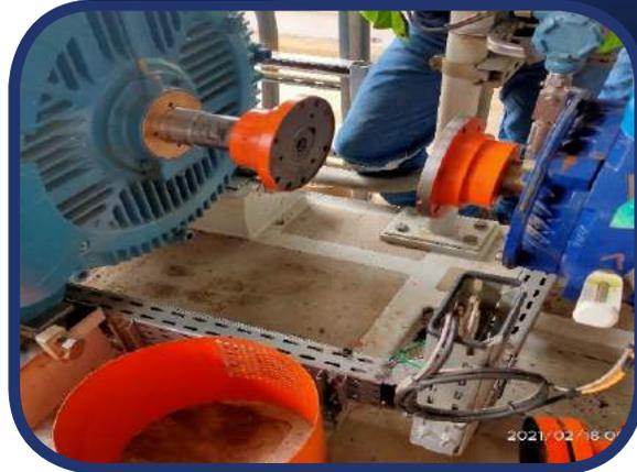
Alineación y montaje del motor y bomba 50LA-C12AP001. Bloque 50.
