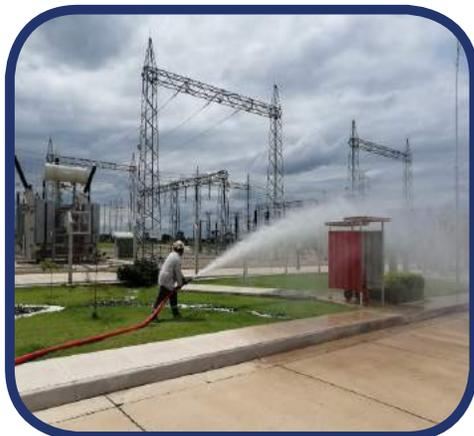
*Inspección y pruebas de caudal en sistema de hidrantes contra incendios, Bloque 30.*
