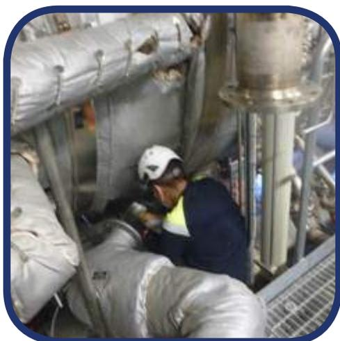
*Desarmado de cooling pipe bridas 1, 2 y 8.*
