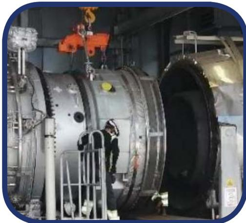
Retiro del Outlet Casing, Turbina de Gas TG32 Bloq. 30.
