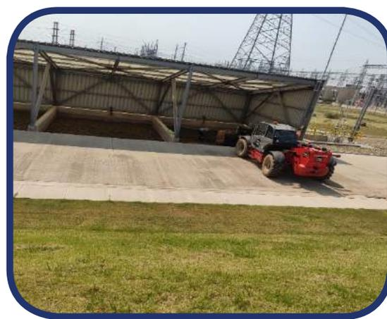
Limpieza y retiro de lodos, con pala cargadora; PTA.
