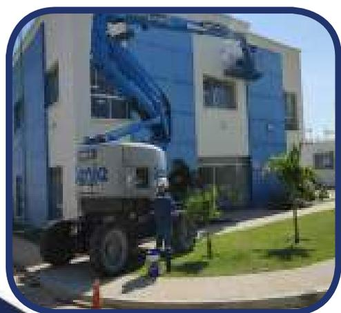
Masillado de fisuras y repintado fachadas en edificaciones, atención de observaciones de punch list.
