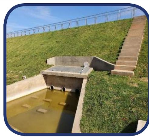
Mantenimiento y limpieza de azolve en obra hidráulica de descarga, laguna N°4.
